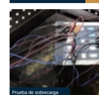
Prueba de sobrecarga
